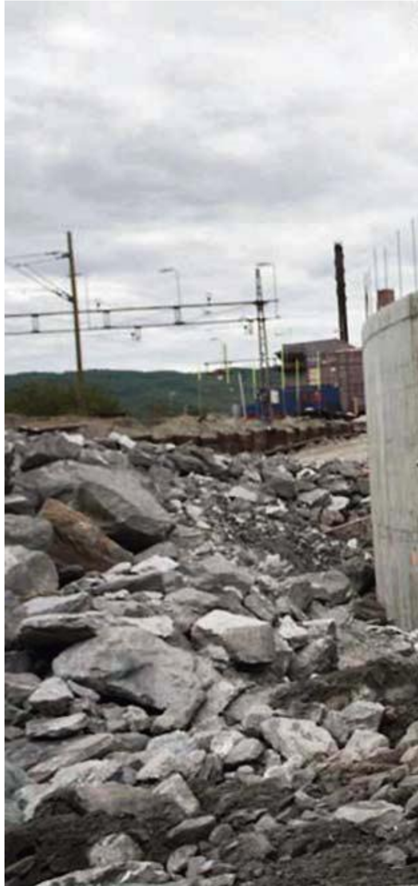
ANLEGG: Ann var en av to prosjektledere ved det store SILA anlegget på LKAB i Narvik.
